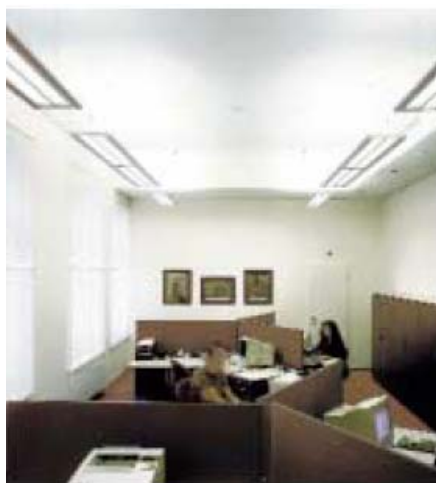
Slika 3.11: Postavitev svetilk v klasičnih in kombiniranih pisarnah.
