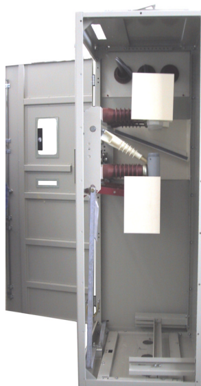
Slika 1.1: Izgled celice CN 4 K brez bočne stene
