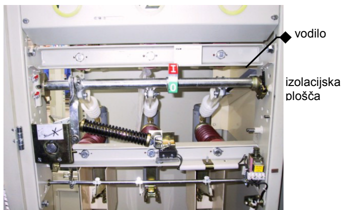
Slika 3.11: Vodila za izolacijsko zaščitno ploščo
